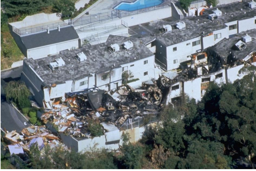
Resim 1.1. 1994 yılındaki Northridge depreminde meydana gelen hasar (Kaynak: Eplett, 1994)
